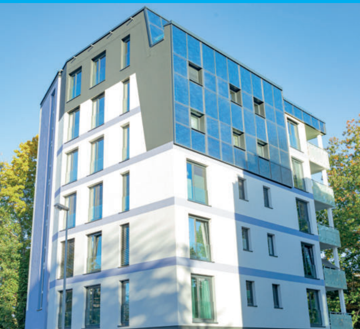
Modernes, innerstädtisches Mehrfamilienhaus mit 50 % solarer Deckung für Heizung und Warmwasser bei 178 m 2 Kollektorfläche
