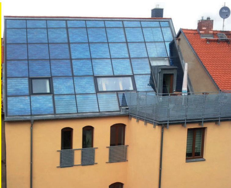
Individuell angepasste Solarthermie-Anlage mit integrierten Dachflächenfenstern (denkmalgeschützter Altbau, Freiberg, erbaut 1530)
